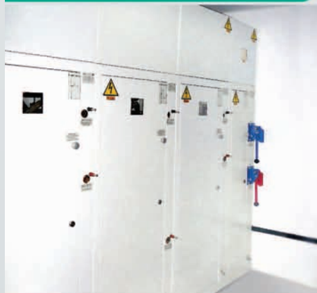
Распределительное устройство 10 кВ
